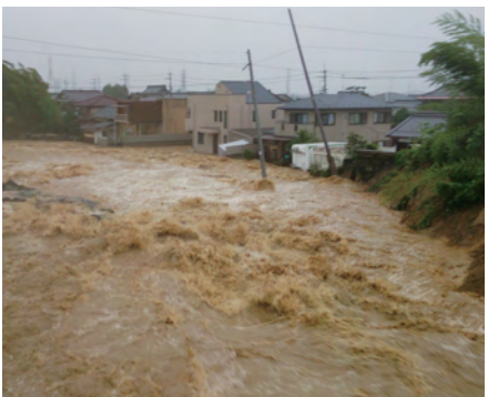
金勝川の破堤(栗東市)
