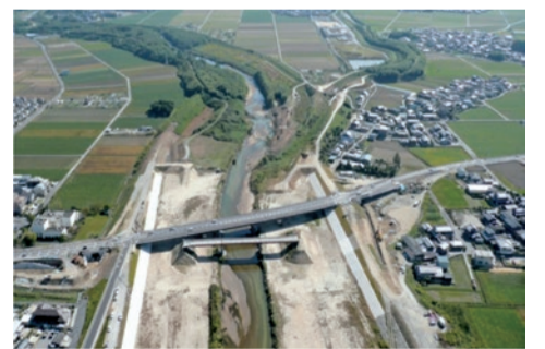
河川改修の様子(日野川)
