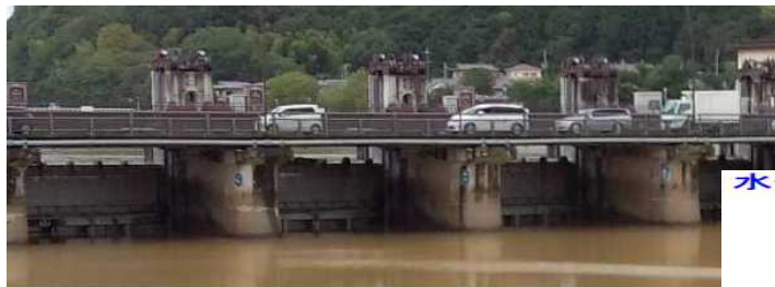
瀬田川洗堰全閉状況：下流右岸より撮影
