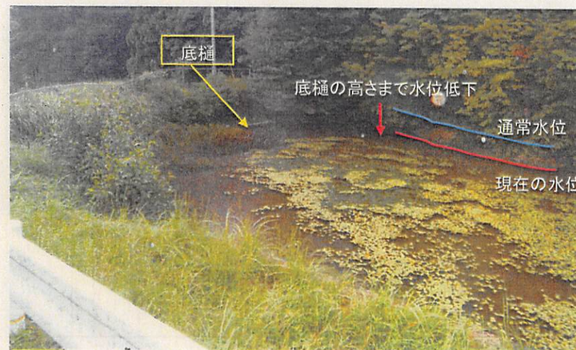
西の谷溜(日野町):水位低下と低水位管理による堤体等の安全性確保
