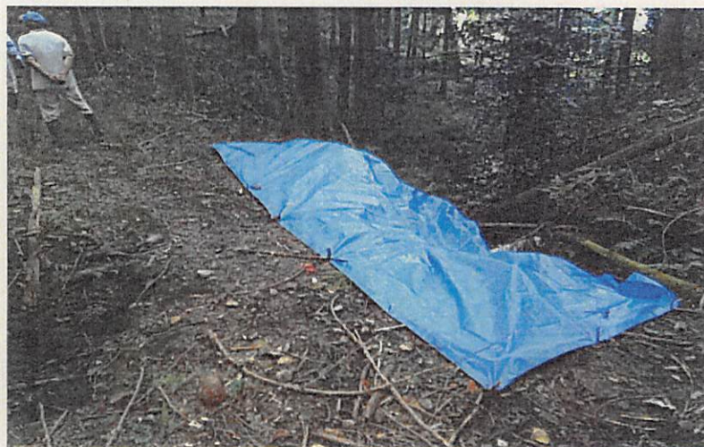
伊蔵ノ池(大津市):ブルーシートによる堤体保護
