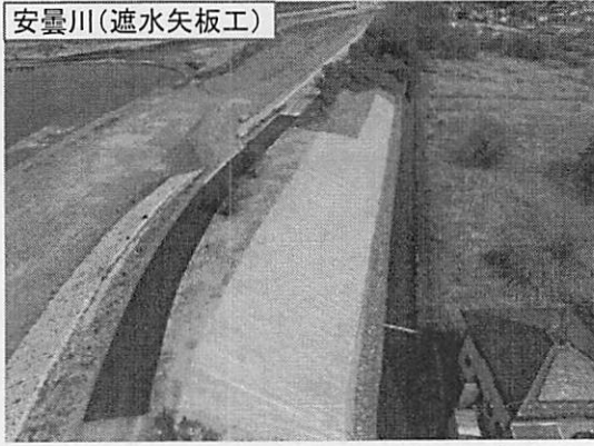
安曇川(遮水矢板工)
