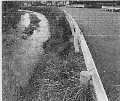
護岸補修等（千丈川）
