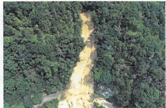
平成 30 年 7 月豪雨被害(高島市鵜川地先)
