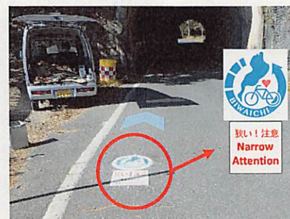
注意喚起の路面表示の設置 (狭小トンネル入口)
