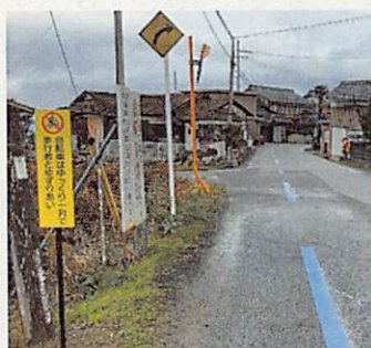
注意喚起看板の設置 (生活道路入口)
