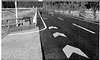
自転車走行空間整備
