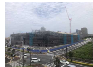
（（仮称）草津市立プール 整備状況（令和5年6月）
