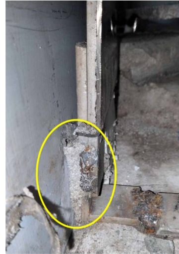
図25 L字金具の接触 状態
