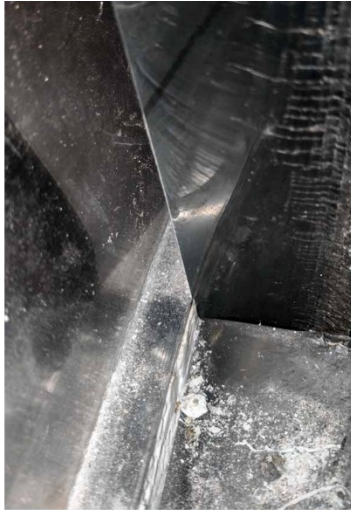
図23 アクリルへのステンレス製 巾木の食い込み
