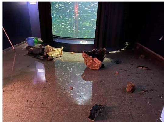
図6 他の水槽前まで散乱した擬岩の破片
