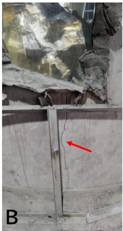
図26 水槽背面の状況 A・B:アクリルに塗布されたモルタル。あちこちにひび割れが生じている。C:擬岩を設置する鉄骨。鉄骨の一部はモルタルに接している。D:擬岩とアクリルの端を隠すために施されたシリコン。擬岩とアクリルの中の緩衝材にはなっていない。
