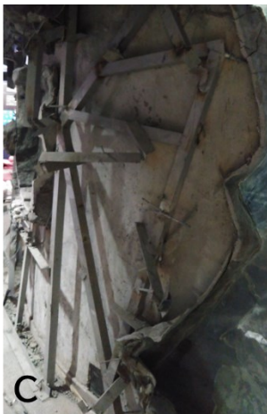
図26 水槽背面の状況 A・B:アクリルに塗布されたモルタル。あちこちにひび割れが生じている。C:擬岩を設置する鉄骨。鉄骨の一部はモルタルに接している。D:擬岩とアクリルの端を隠すために施されたシリコン。擬岩とアクリルの中の緩衝材にはなっていない。
