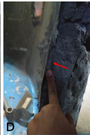
図26 水槽背面の状況 A・B:アクリルに塗布されたモルタル。あちこちにひび割れが生じている。C:擬岩を設置する鉄骨。鉄骨の一部はモルタルに接している。D:擬岩とアクリルの端を隠すために施されたシリコン。擬岩とアクリルの中の緩衝材にはなっていない。
