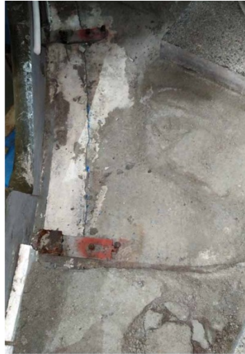
図24 嵩モルタルと緩衝材の設置 状態
