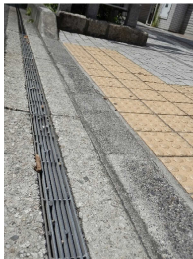
画像8 車道との段差に配慮した歩道
