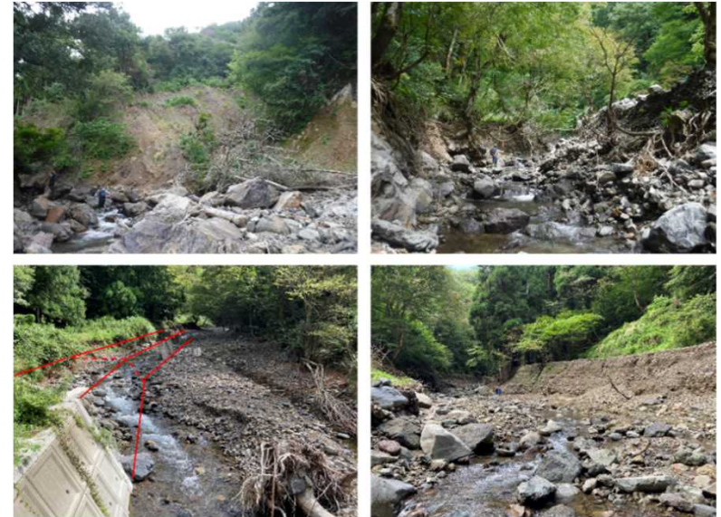
現地調査状況 (針川)
