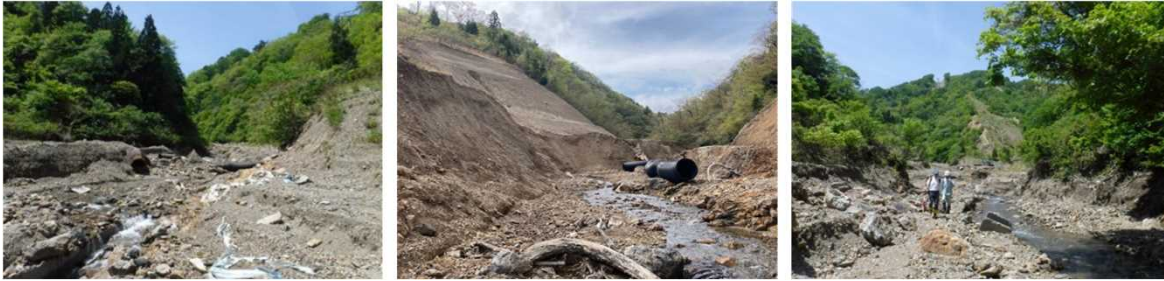
現地調査状況 (大音波谷川、スキー場跡地)
