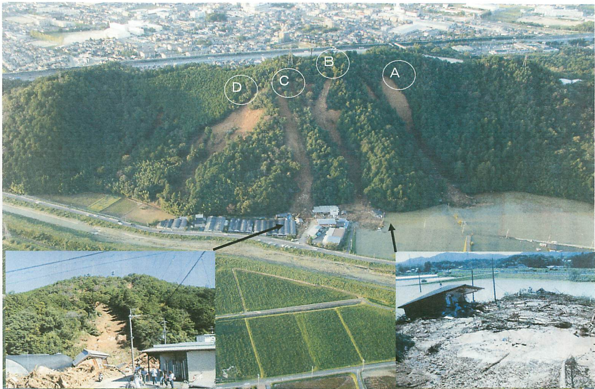
山腹崩壊(栗東市下戸山) 死者1名 人家全壊 3戸
