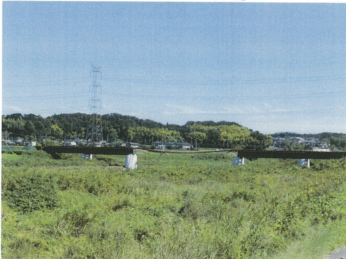
① 杣川橋梁流失現場（貴生川起点 733m）【全景】
