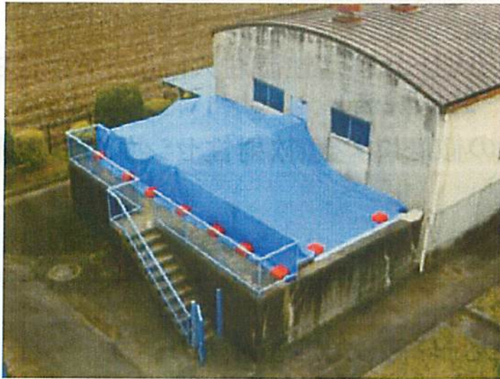
【筑西市 成田浄水場 着水井 覆蓋】
