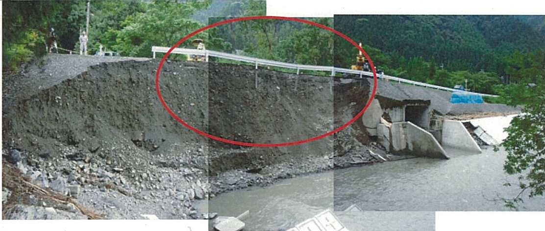
■砂10 こも谷(高島市高島富坂) 土砂流出・堆積による河道閉そく
