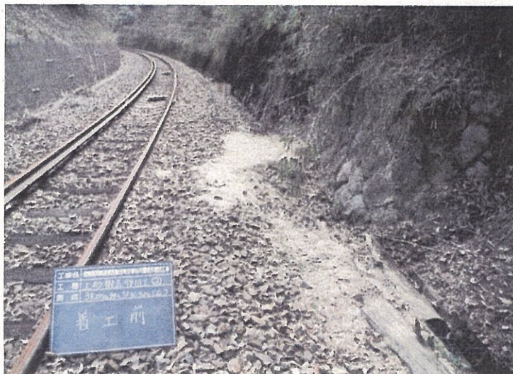
（工事前）壁面の崩壊
