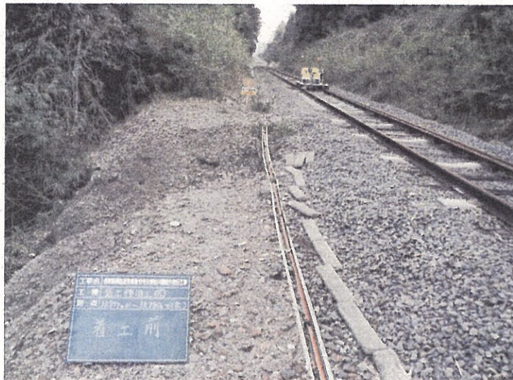
（工事前）壁面の崩壊
