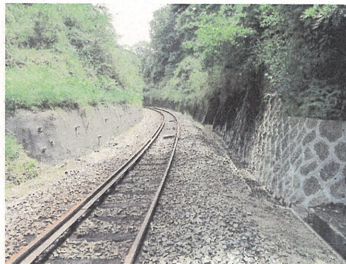
（工事後）防護壁の施工
