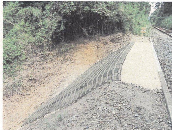
（工事後）防護壁の施工
