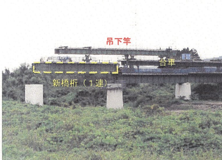
3 工事中（新たな橋桁を設置） H26.9 撮影
