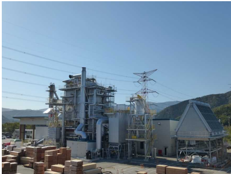
木質バイオマス発電所(米原市大野木)
