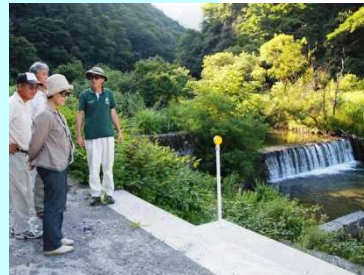
発電所予定地
