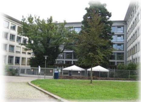
現場施工技術者の養成学校 (リヒルト・フェーレンバッハ職業学校)
