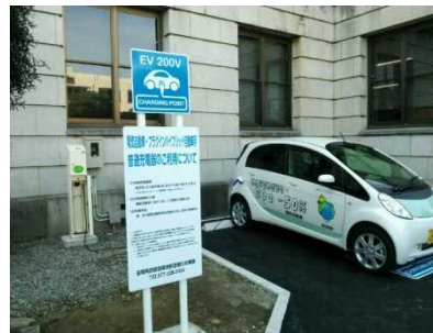
H26.3 県庁設置充電器
