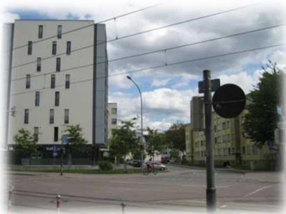
省エネ改修と地域暖房 (ワインガルテン地区)
