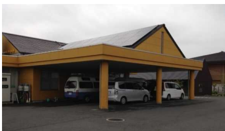
⑯コナン市民共同発電所 初号機 (障がい者支援施設「バンバン」)
