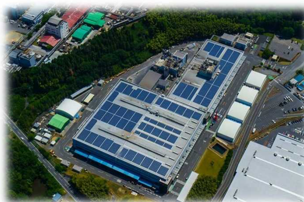
セキスイボード(株) 【甲賀市：1.0MW】
