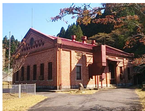
大戸川発電所 (大津市上田上牧町)
