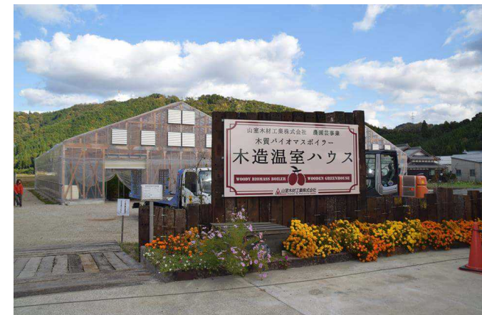
木質バイオマスボイラーを熱源とした 木製温室ハウス(長浜市)
