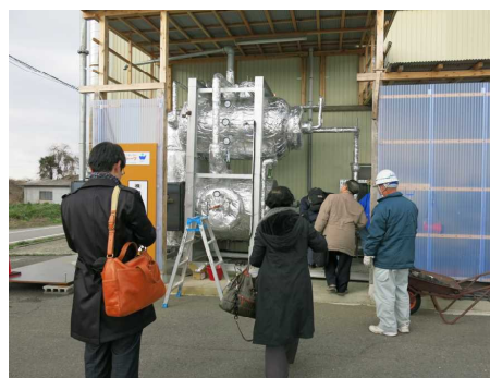
図 3-21 過年度における支援事例② (間伐材を利用した簡易温水ボイラーの開発)
