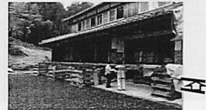
曳家による嵩上げ
