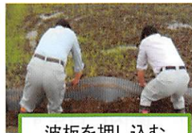
波板を押し込む
