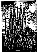
写真（建設中のサグラダ・ファミリア）
