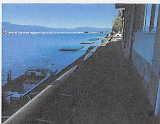
漕艇場管理棟前の通路（犬走り）
