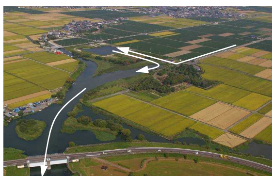
河川直接浄化事業の例(植生浄化)
