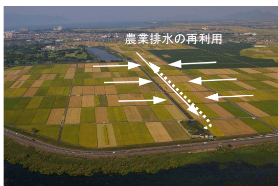
循環かんがい施設の例(木浜地区)
