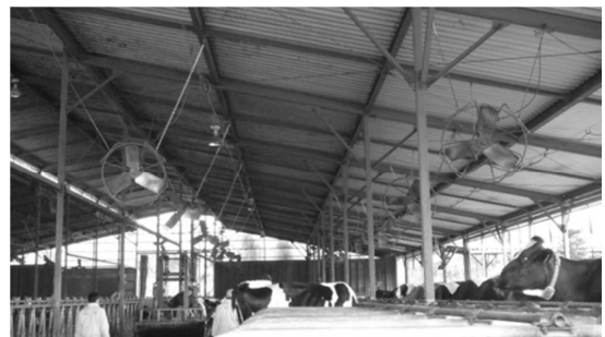
酪農牛舎に設置された大型ファン
