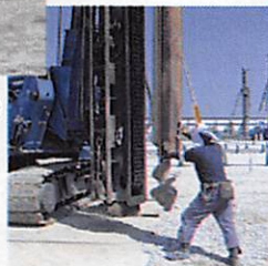
オーガ併用圧入工法 施工写真(例)
