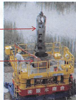
オールケーシング工法 施工写真
