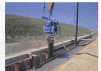
鋼矢板打設 施工写真(例)
