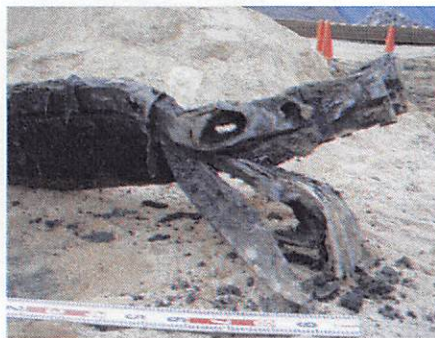
建築系の大型の鋼材
