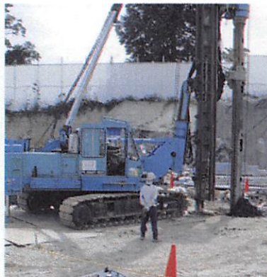
オーガ併用圧入工法 施工写真(A区画)
