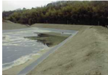
④ 沈砂池の設置 （平成14年11月完了）
