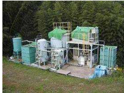
② 処理施設の設置 （平成14年11月完了）
