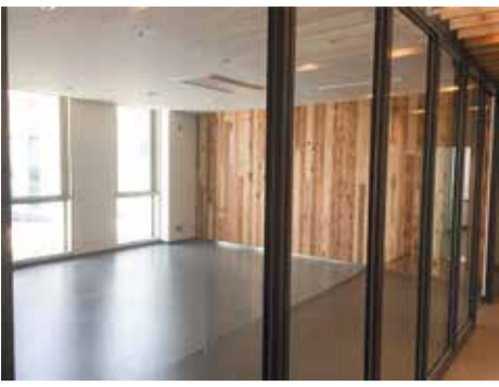
CLTを活用した薬業技術振興センター内部
