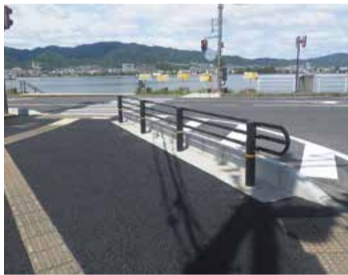
交差点に設置された防護柵
