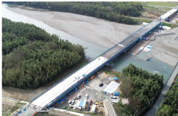
常安橋(高島市)の工事の様子
