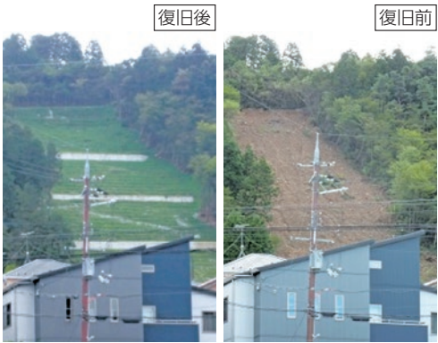
平成25年台風18号による山腹崩壊の復旧
