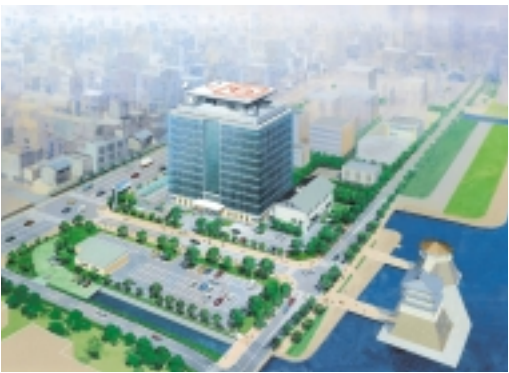
滋賀県警察本部新庁舎（平成20年完成予定）
