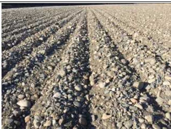
河床耕うんの様子 （縦断方向完了、横断方向未施工）
