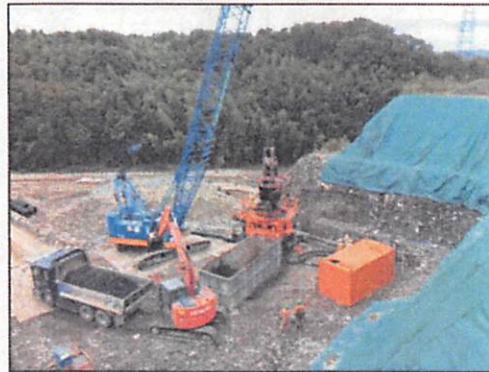
ケーシング工法 施工事例写真
