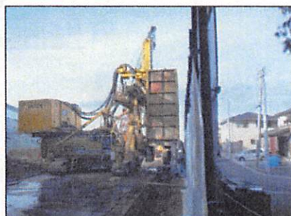
鉛直遮水工施工事例写真
