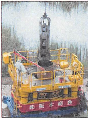
ケーシング工法 施工事例写真
