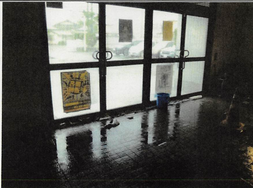
撮影項目 科学捜査研究所 玄関ホール浸水状況
