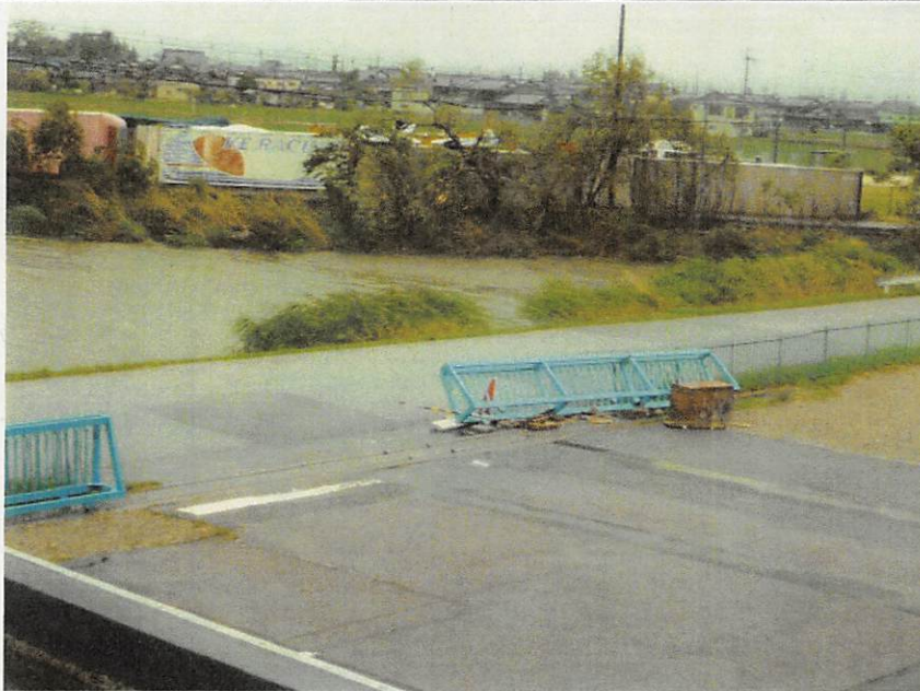
撮影項目 運転免許センター 正面門扉倒壊状況
