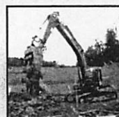
【ため池堤体改修工事】
