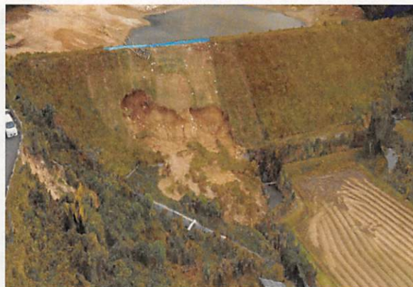
図VI-3 貯水位の上昇によりパイピング破壊したため池（他県例）
