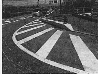
写真：防護柵設置①
