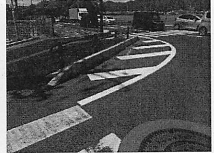
写真：防護柵設置②
