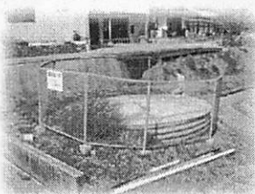
抑制工(集水井)
