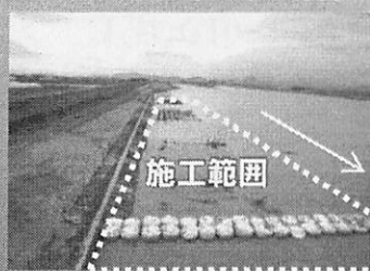
施工直後 (平成22年4月23日)
