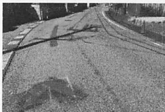
路面標示整備例(彦根市)
