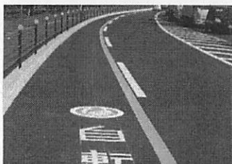
自転車通行帯整備例(守山市)
