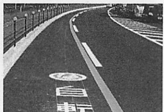
自転車専用通行帯整備例 (守山市)
