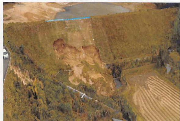
図VI-4 貯水位の上昇によりパイピング破壊したため池（他県例）
