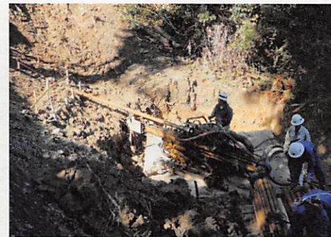
水抜き工の施工状況
