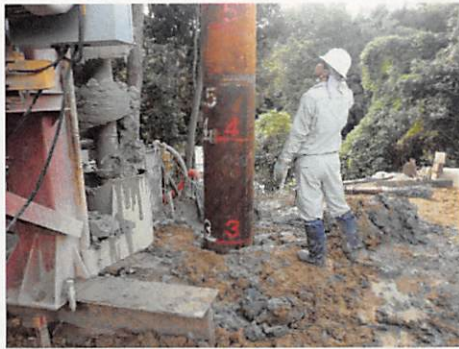
抑止杭工の施工状況
