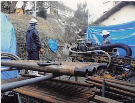
水抜き工の施工状況
