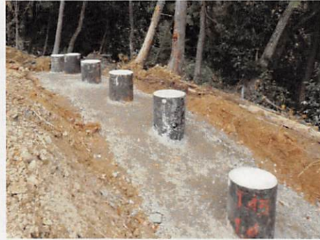
抑止杭工の施工状況
