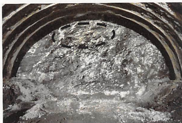
図) 重金属含有土の発生状況〔左：鏡面の状況、右：黄鉄鉱を含む岩塊〕※囲った部分で黄鉄鉱を確認
