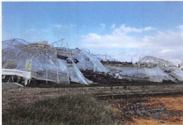
台風21号による農業用ビニールハウスの倒壊（2018年9月）
