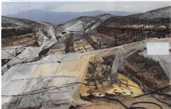
台風21号による農業用ビニールハウスの倒壊（2018年9月）
