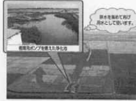
循環かんがい施設(木浜地区)
