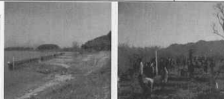
ヨシ群落造成工事実施箇所（野洲市菟淵地区）
