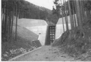
日野谷川堰堤（甲賀市）
