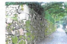
穴太衆積み石垣
